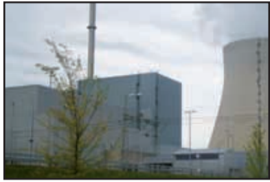
Atomkraftwerk Isar 1 ist reif für die Stilllegung. Seite 2
